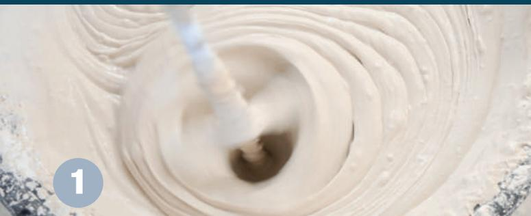
Verser lentement le produit jusqu'à saturation (équivalent à environ 2,1 kg de poudre pour 1 litre d'eau) dans un seau propre, contenant de l'eau claire. Laisser reposer 2 à 3 minutes et mélanger avec un malaxeur à hélices jusqu'à l'obtention d'une texture homogène.
