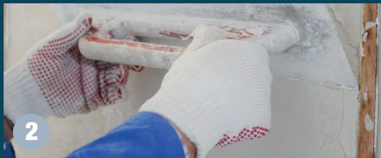
Sitôt après le gâchage, appliquer à la spatule ou à la taloche métallique (lisseuse) en fonction de l'utilisation à laquelle il se destine. Pour la réparation de fissures, il est recommandé d'agrandir ces dernières afin de faciliter la pénétration en profondeur de l'enduit, tout en augmentant la superficie de la zone de réparation, ce qui permet une meilleure couverture de cette dernière. Dès que l'enduit devient trop dur ne doit plus être utilisé, ni rallongé avec addition d'eau.
